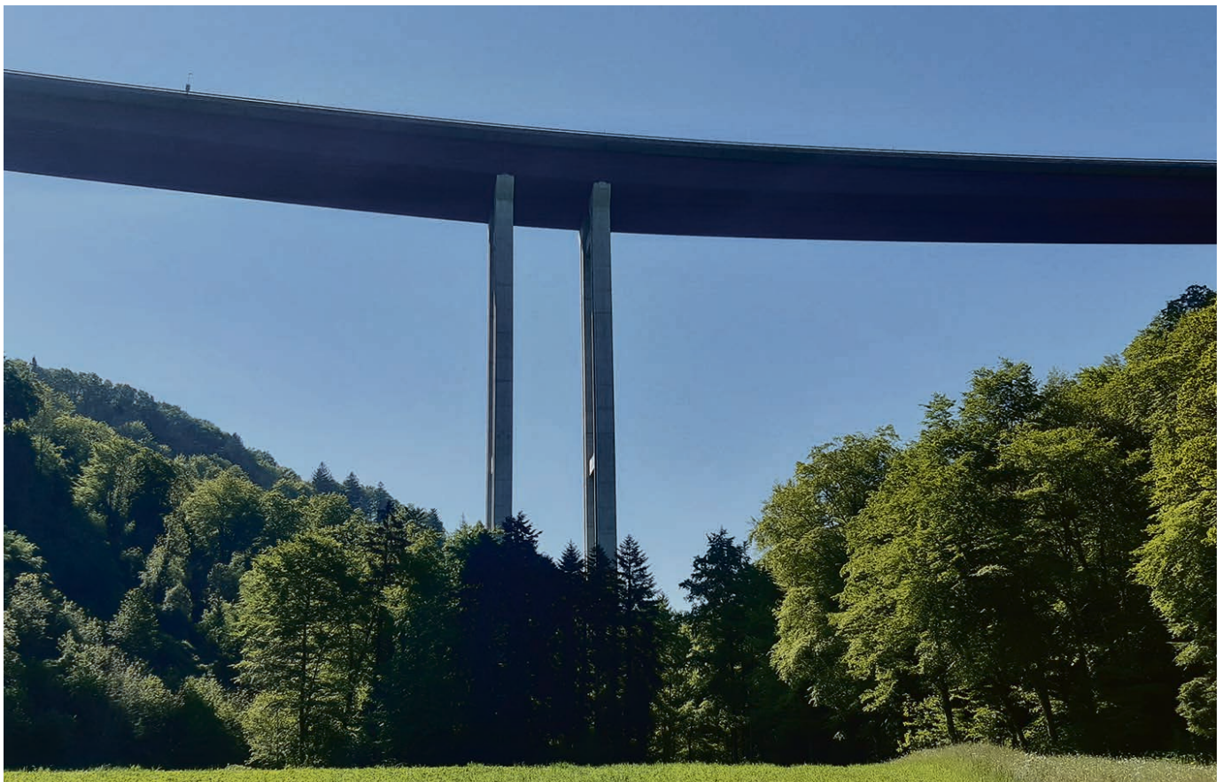
Le viaduc des Vaux - Yverdon. © Marcus Heutmann
